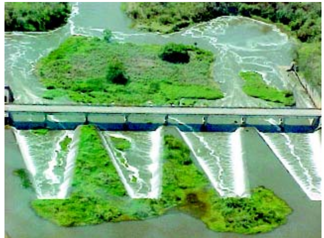
Vertedouros da barragem Foto: CILSJ
